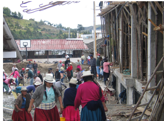
Die ganze Gemeinde hilft beim Schulhausbau (minga)
